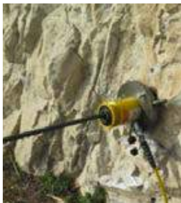
Prove di snervamento e rottura delle barre
