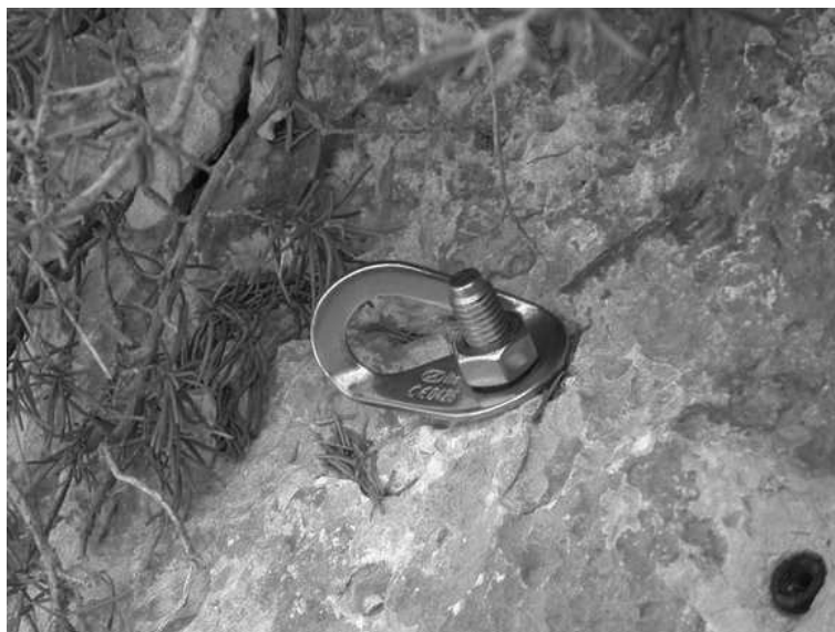
Figura 3.4: Esempio di tassello ad espansione installato. Immagine tratta da https://www.falesia.it (al 02/10/13)
